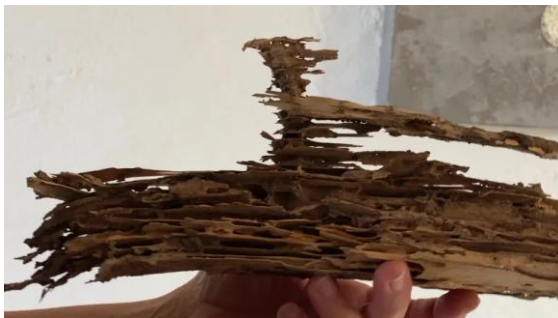
Restes de poutre après une attaque de termites
