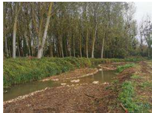
Après travaux : oxygénés, radiers, fosses, habitats
